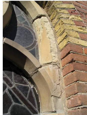
Zandstenen trasering zuidwestgevel
