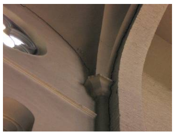
Scheuren tussen de gewelven van het middenschip en de wanden
