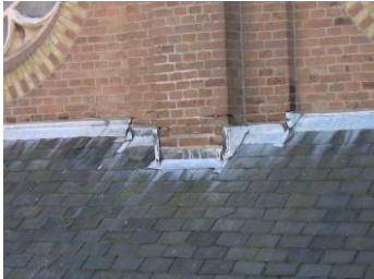
Aansluiting middenschip op dak zijbeuk
