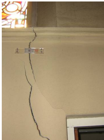
Scheur in zijbeuk bij de doorgang sacristie
