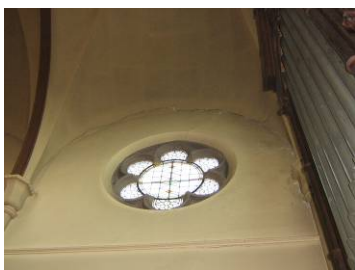
Scheuren tussen de gewelven van het middenschip en de wanden
